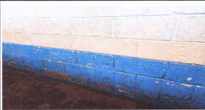
Foto 7: PINTURA EN MUROS EXTERIORES (ZÓCALO) PINTURA DE ACEITE MARCA CELCO.
