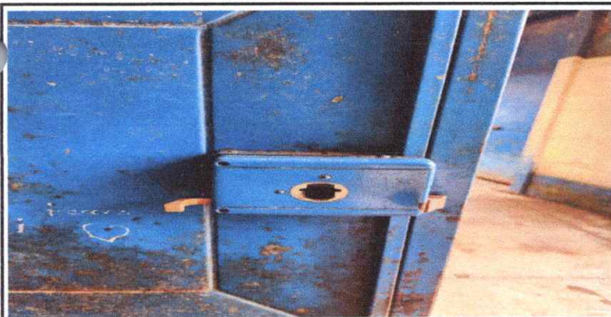
Foto 5: SUSTITUCIÓN DE CHAPA MARCA YALE.
