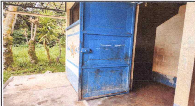
FOTO 4: MANTENIMIENTO A PUERTAS: LIJADO, CEPILLADO, PULIDO Y PINTURA ANTICORROSIVO R15 MARCA CELCO.
