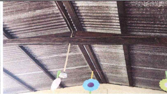
Foto 2: SUSTITUCIÓN DE ESTRUCTURA DE SOPORTE DE MADERA POR METAL, RECTANGULAR CHAPA 16 DE 6X2 Y TUBO RECTANGULAR DE 3X2.
