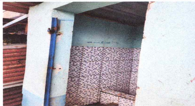
Foto 9: SUSTITUCIÓN DE PUERTA POR REJA DE METAL.
