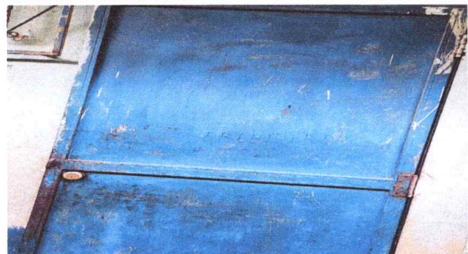
Foto 3: MANTENIMIENTO A PUERTAS: LIJADO, CEPILLADO, PULIDO Y PINTURA ANTICORROSIVO R15 MARCA CELCO.
