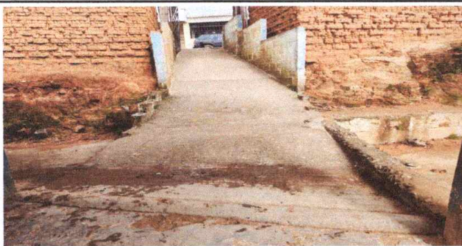
Foto 11: REPARACIÓN DE BANQUETA E INSTALACIÓN DE GRADAS DE LA ENTRADA PRINCIPAL.
