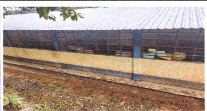
Foto 8: PINTURA EN MUROS EXTERIORES E INTERIORES PINTURA DE AGUA MARCA CELCO.
